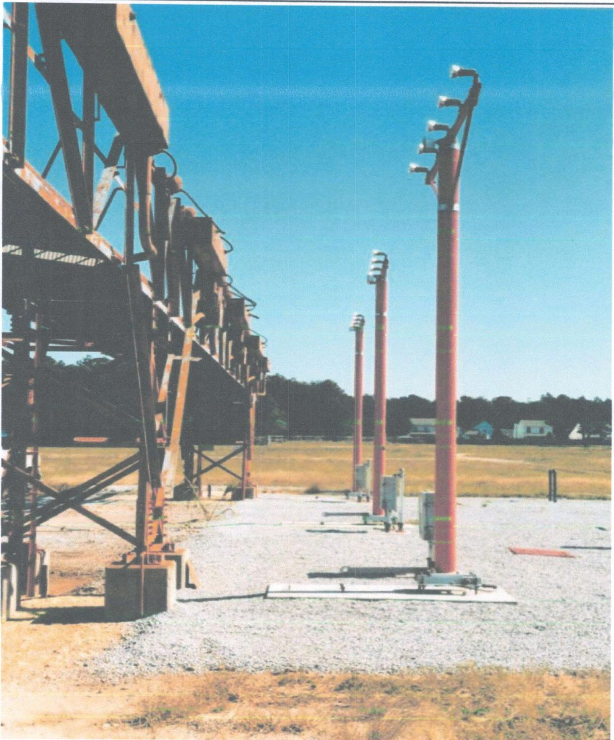
**Рис. 4-6. Установка огней приближения жесткой конструкции (слева), заменяемая новыми ломкими конструкциями (справа)**
