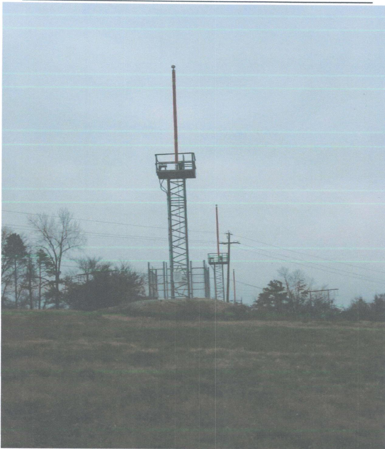
**Рис. 4-7. Стеклопластиковый трубчатый столб на жесткой опоре**
