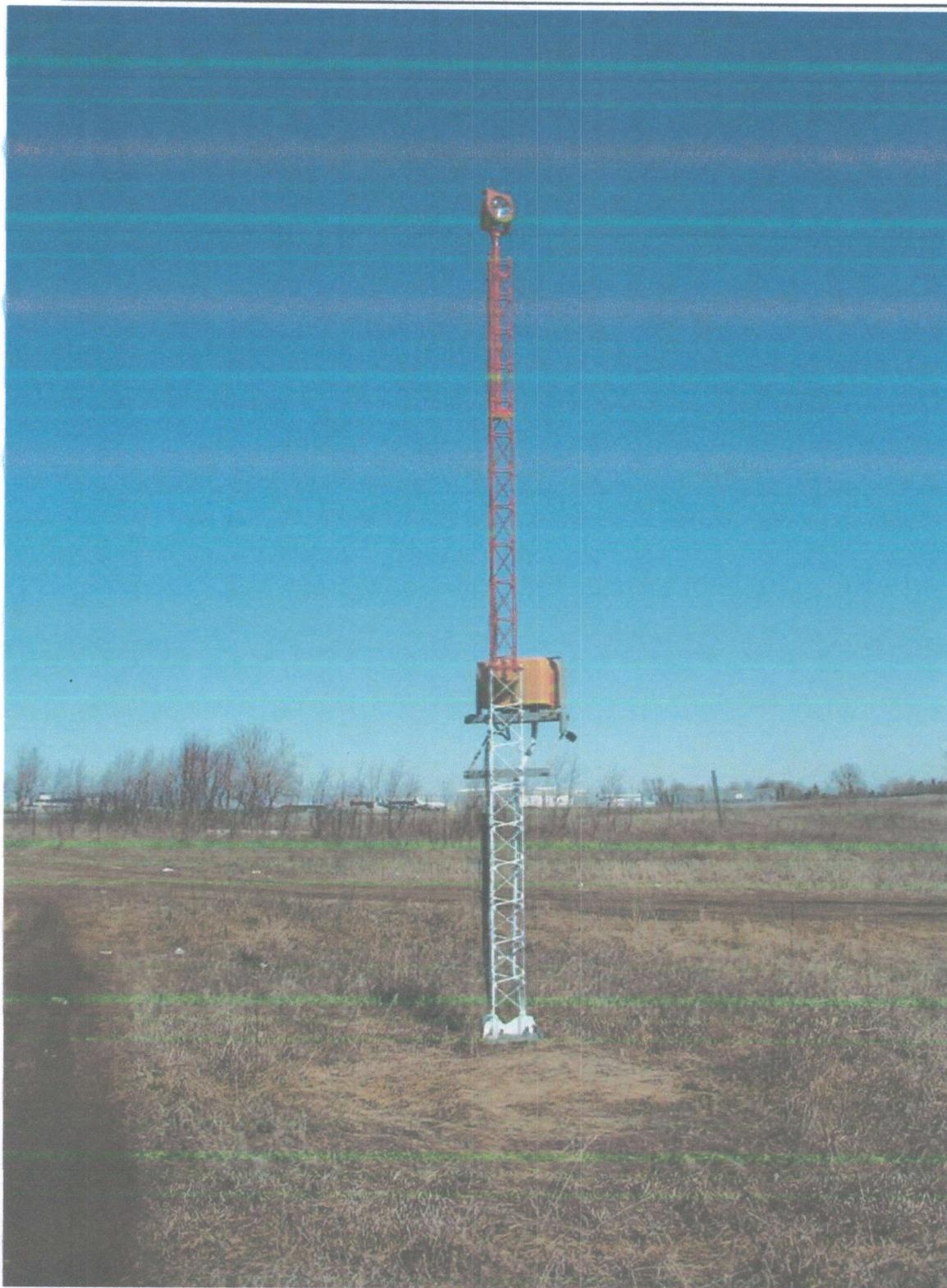
**Рис. 4-5. Опора огня приближения крупным планом – алюминиевая решетчатая конструкция**
