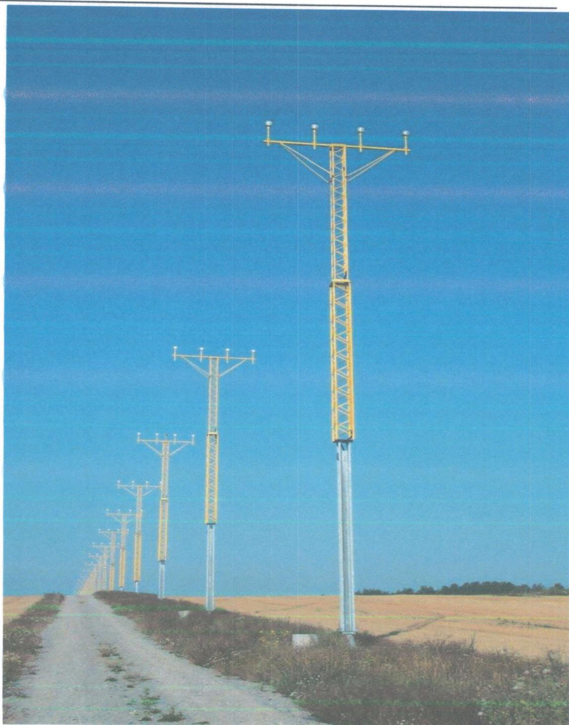
**Рис. 4-8. Стеклопластиковые опоры огней приближения на жестких поддерживающих конструкциях**
