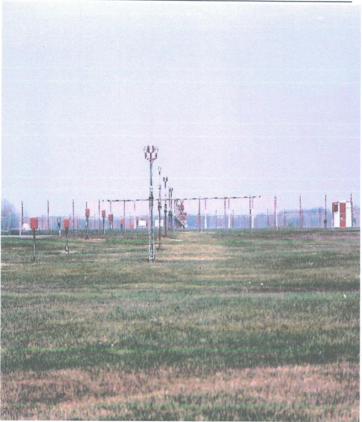
**Рис. 4-4.** Опоры огней приближения – алюминиевые решетчатые конструкции
