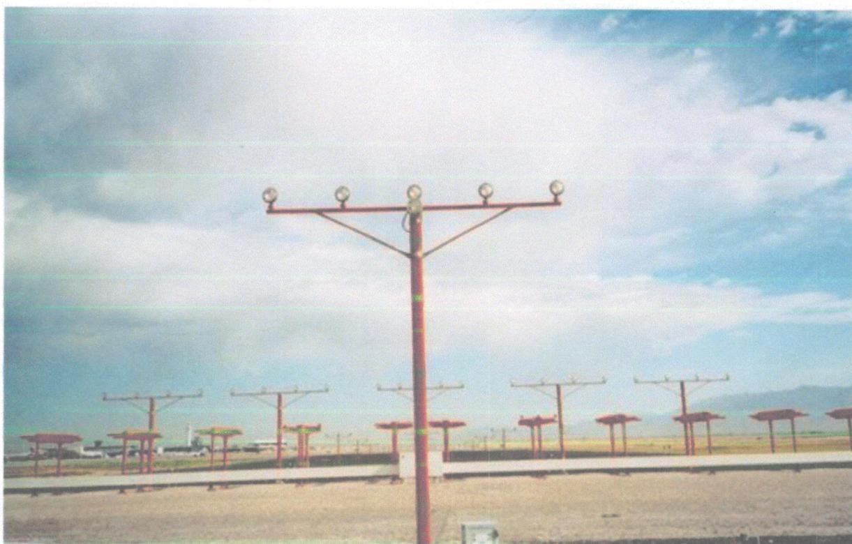
**Рис. 4-3. Опоры огней приближения – стеклопластиковые трубчатые столбы**
